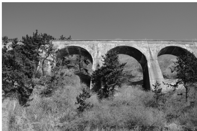
数箇所に残る橋梁
