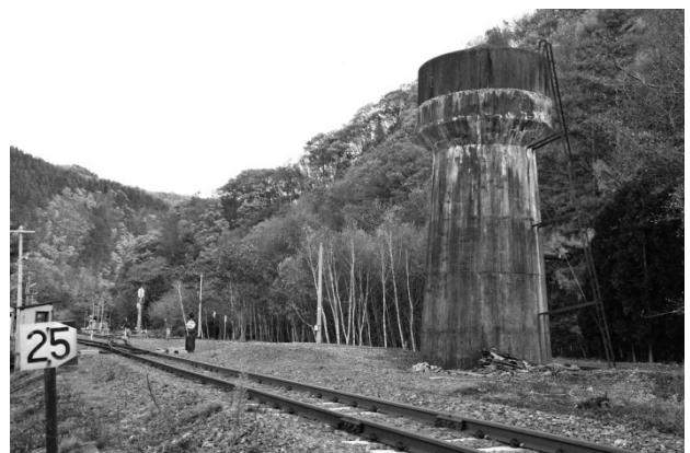
森閑とした山中の駅に残る給水塔 山田線 川内駅 2014年10月
